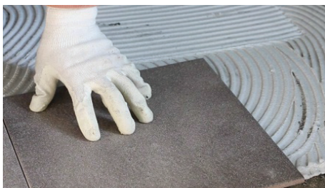
Монтаж мата в плиточный клей
