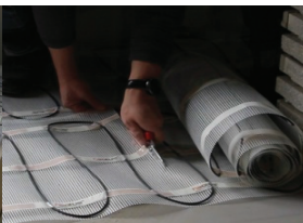
Резка сетки (кабель не режется)
